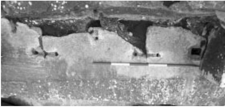
10 Kalkmörtelverfüllungen zwischen Stufenblöcken und Felssockel an der Westseite
