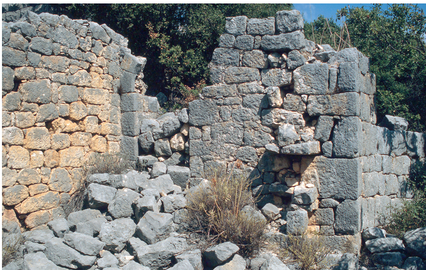
Abb. 7: Basilika, nördliches Seitenschiff, östliches Ende nach Nordosten (Foto: Verf.)
