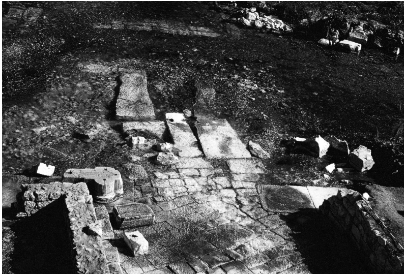
Abb. 9: Nordansicht der Brücke (Neg. Nr. Li 01/634627, Foto: L. FLIESSER)
