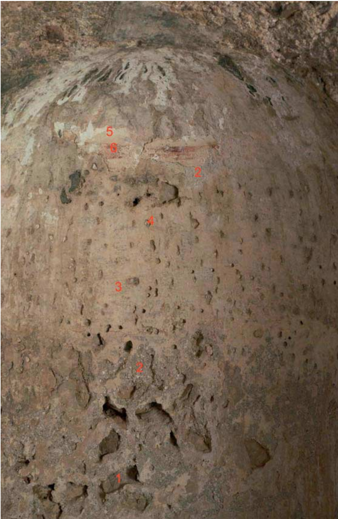
Abb. 18: Nische 7 mit Hackspuren und Freskorestern: 1 – Stein- und Ziegelmauer 2 – grauer Verputz über Mauer 3 – darüber hellbrauner Verputz (Untergrund für erste Freskophase?) 4 – in diesem Verputz (3) kleine absichtlich geschlagene Löcher, um weitere Verputzschicht besser haften zu lassen. 5 – darüber weitere Verputzschicht (=Fresko-Unterlage?) 6 – Fresko (rote Farbreste)
