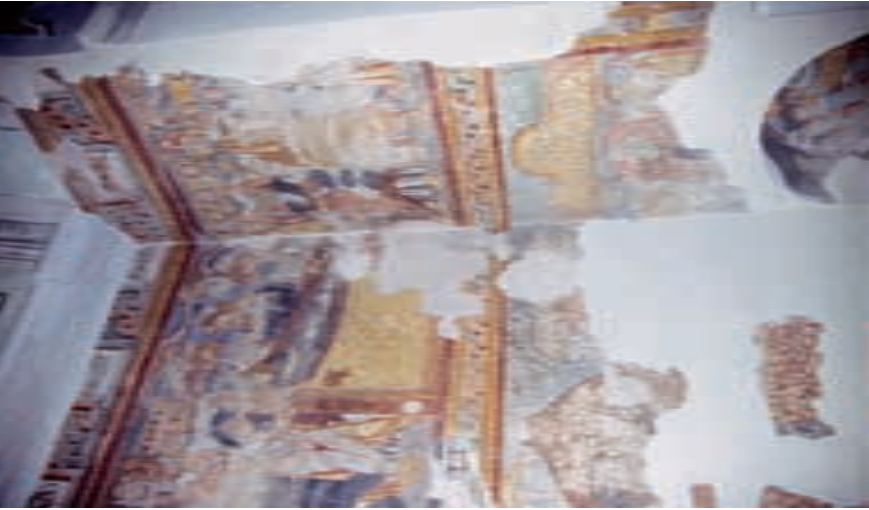
2 Untermais, Maria Trost, Saalraum mit Wandmalereien, NO-Ecke
