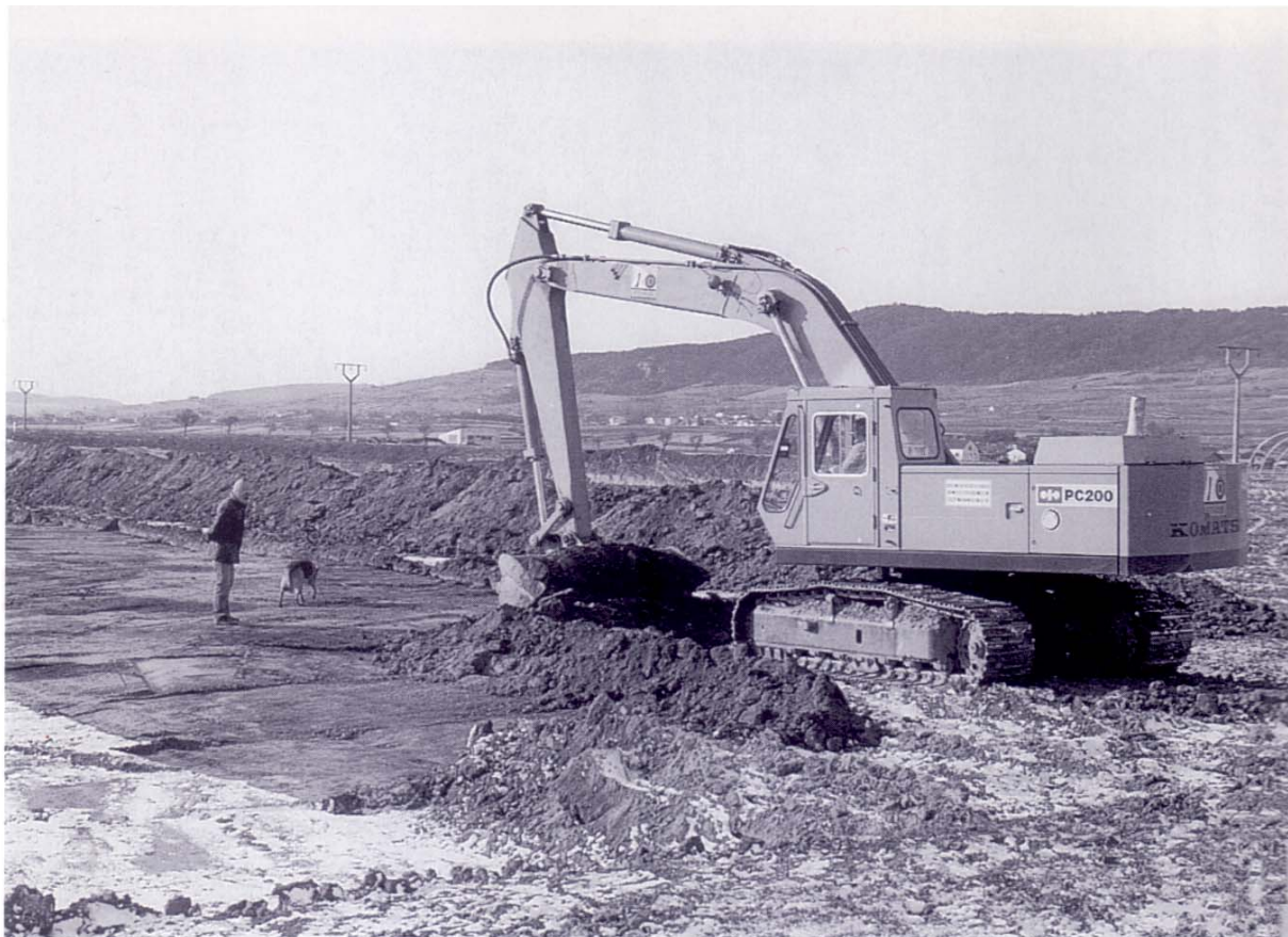
Abb. 16: Abtragen des Humuspaketes mit dem Löffelbagger (nach Neugebauer und Neugebauer 1997, Taf. 670/1).
