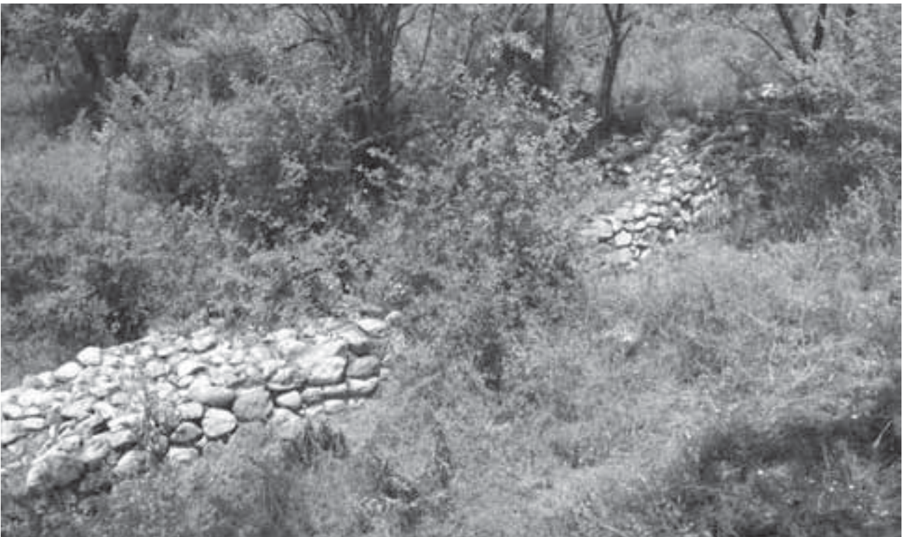
4 Fundamente der Befestigungsmauer östlich der alten Metropolitankirche Hosios Nikolaos (von O)
