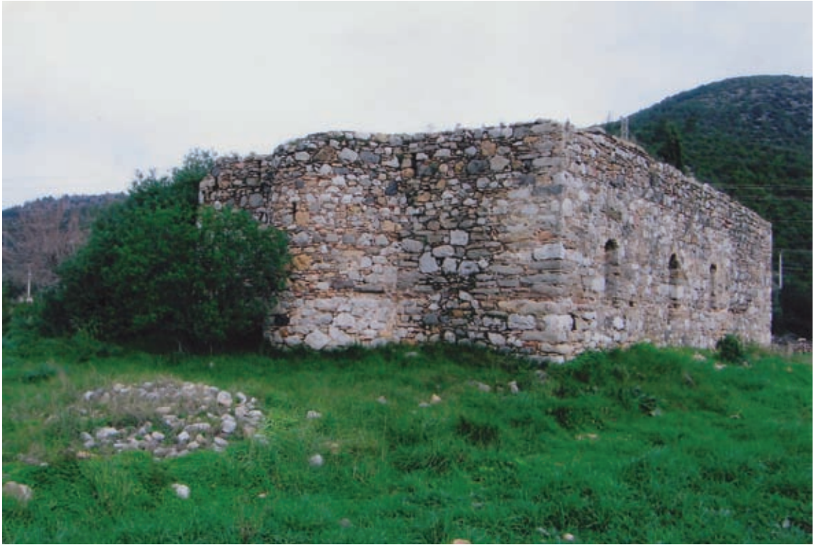
Abb. 1: Gerekyu Dere, frühbyzantinische Therme, Ansicht von Südwesten
