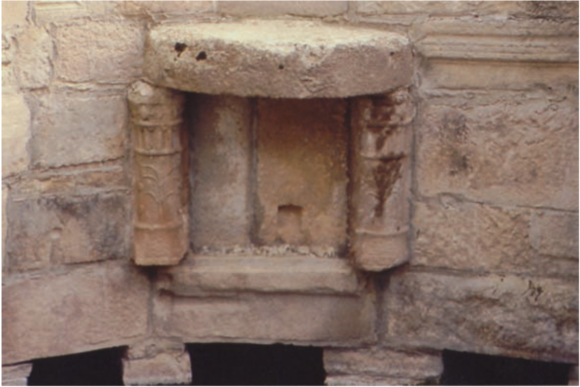
Abb. 60: Damla, frühbyzantinisches Fenstersäulenpaar
