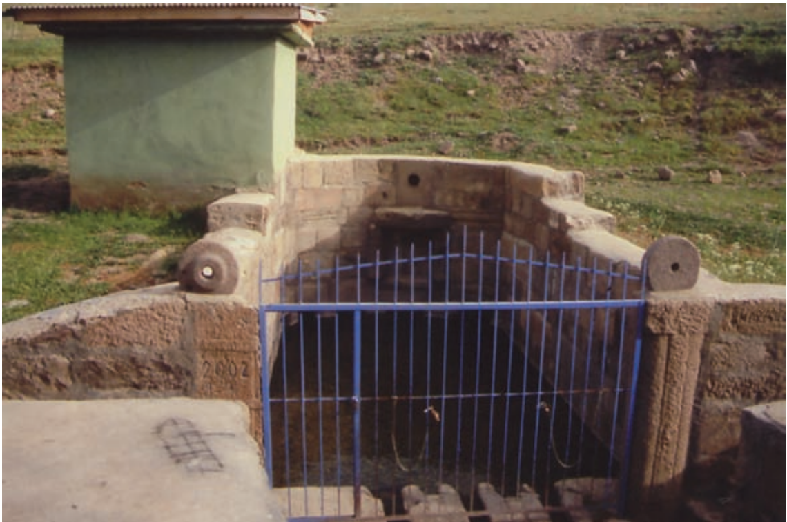
Abb. 61: Damla, Quelleinfassung vor dem Dorf aus frühbyz. Spolien errichtet i. J. 2002
