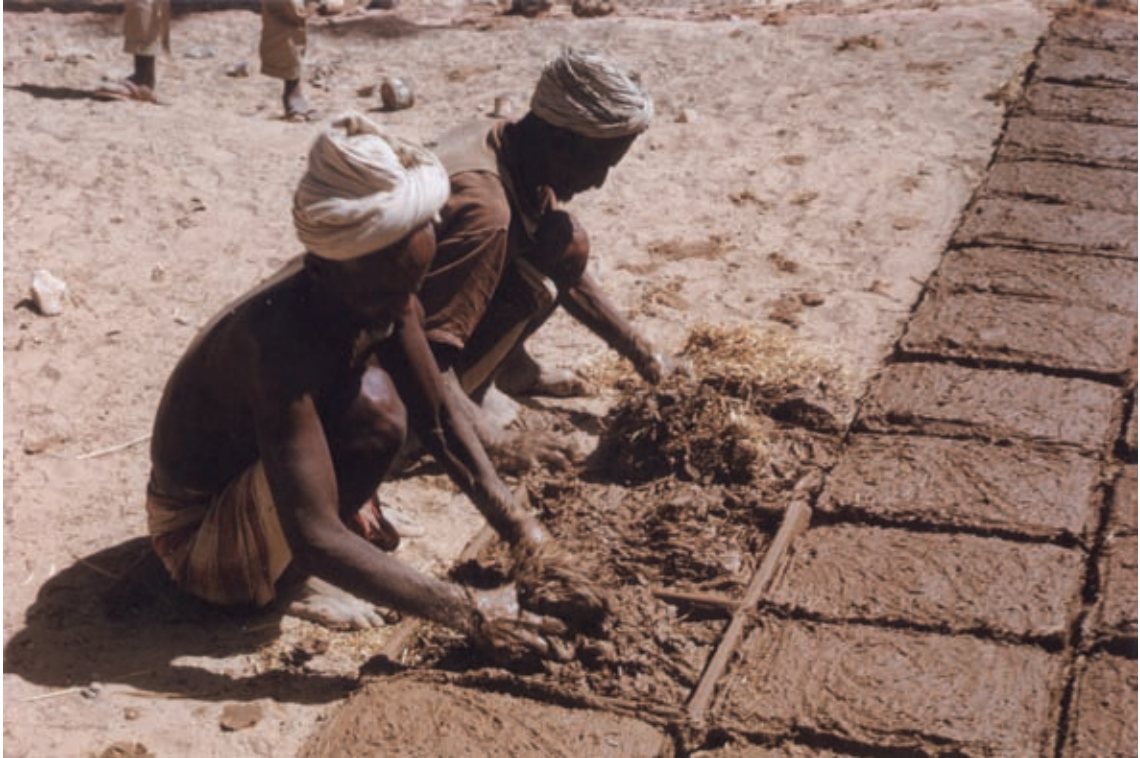
Abb. 18: Lehmziegelherstellung: Verstreichen des mit Häcksel vermengten Lehms in Ziegelrahmen (1966).
