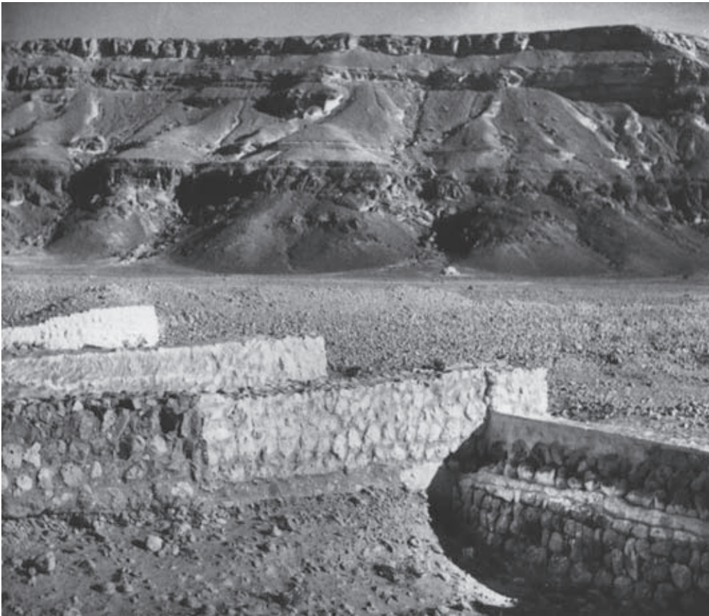
Abb. 25: Im Wadi errichtete Dämme zum Umleiten des von der Kalktafel herabstürzenden Regenwassers (1992).
