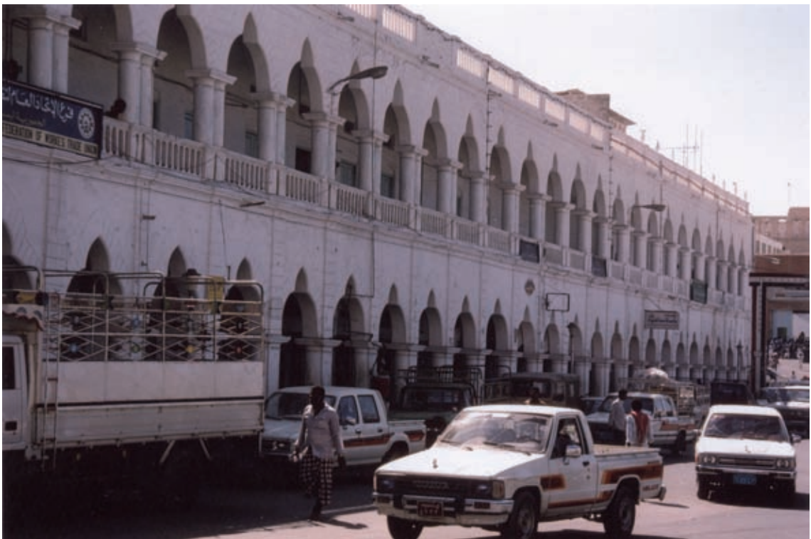
Abb. 34: Zollgebäude in al-Mukalla (1992).
