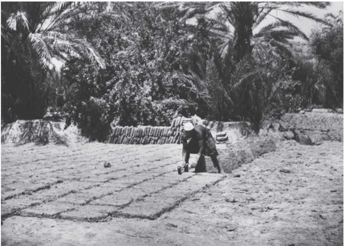
Abb. 19: Wenden der sonnengetrockneten Lehmziegel (1966).
