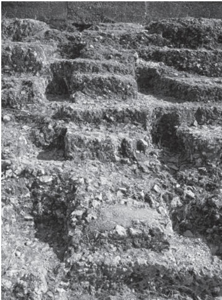
Abb. 15: Ausnehmungen im Unterbau (hier anstehender Fels) an der Kontaktstelle von Sitzstufe und Radialtreppe zur Aufstellung der seitlichen Wangensteine.
