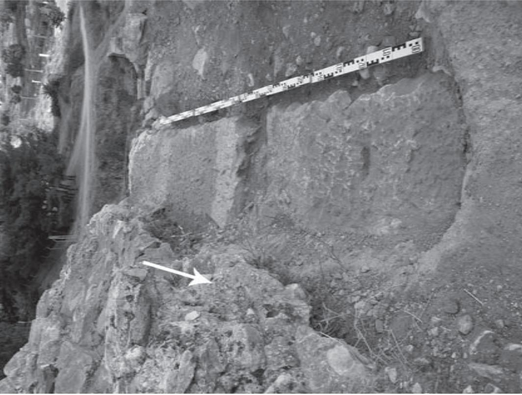
Abb. 25: Fundamentquader der Diazoma-Wand und Anschluss des vermutlichen Füllmauerwerks im oberen rückwärtigen Bereich der Quader. Im Hintergrund moderne Sicherungen der *opus caementitium*-Oberfläche.
