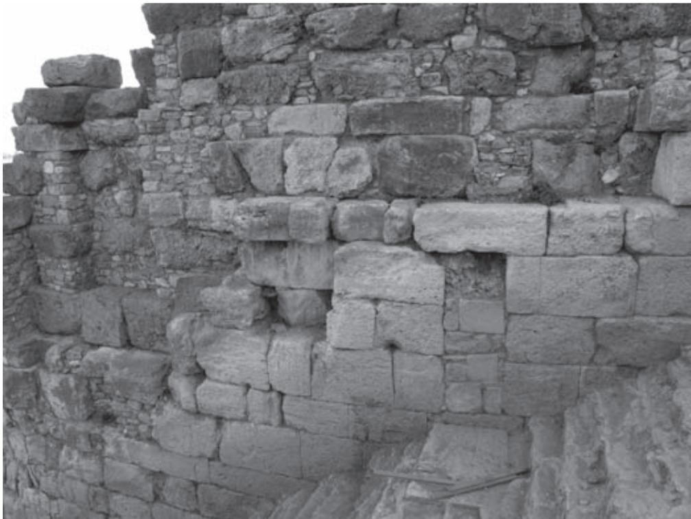
Abb. 8: Ausschnitt der südlichen Außenwand des Theaters. Im unteren Bereich die erhaltenen Fassadenquader, oberhalb die Quader des Mauerkerne mit Mauerplomben aus der Restaurierungsphase.
