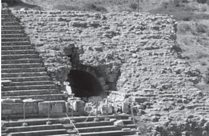
Abb. 9: Südliches Vomitorium zum mittleren Diazoma. In Verlängerung eines Risses, der sich durch den gesamten südlichen Gebäudeflügel zieht, ist der zur Cavea gerichtete Teil des Werksteingewölbes eingestürzt.
