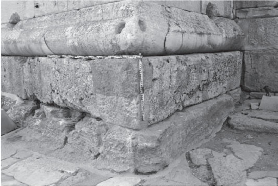
Abb. 38: Südliche Gebäudeecke des Theaters. Die Quader des Fundaments wurden nachträglich auf das Niveau des Straßenbelages abgearbeitet.
