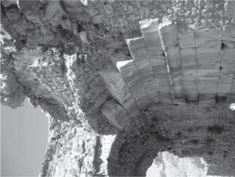
Abb. 4: Unteres südliches Vomitorium. Erhaltene Reste des Werksteingewölbes. Darüber sind die Reste der Substruktionskammer zur Herstellung der Rangneigung sichtbar.
