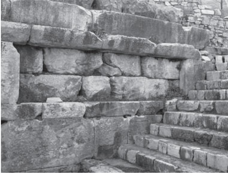
Abb. 5: Unteres nördliches Vomitorium. Im Wandbereich zeigen die Anschlusspunkte des ehemaligen Stufenbelags aus Marmor die bauzeitliche Tritthöhe an.
