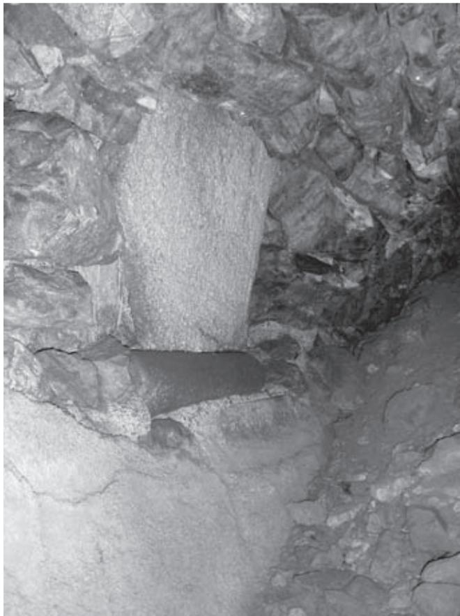
Abb. 35: Gewölbe im Abschnitt I mit eingesetzter Platte.
