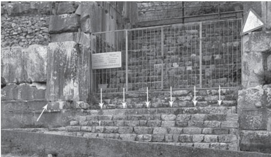
Abb. 28: Westseitiger Zugang zum Vomitorium S1. Im Vordergrund die Nutzung der durchlaufenden Fassadenquader als Unterbau der Treppe. Die übrige Treppenunterbau ist restauriert.
