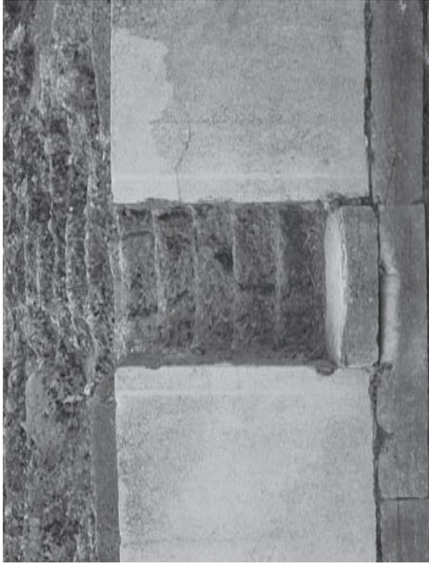
Abb. 24: Sockelsteine als Antrittsstufe der Klimakes (Phase I) und Aufdoppelung der Stufe (Phase II).
