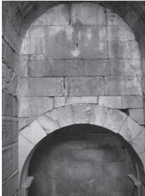
Abb. 27: Theater von Milet, Schildwand zur Vermittlung zwischen zwei unterschiedlichen Gewölbehöhen.
