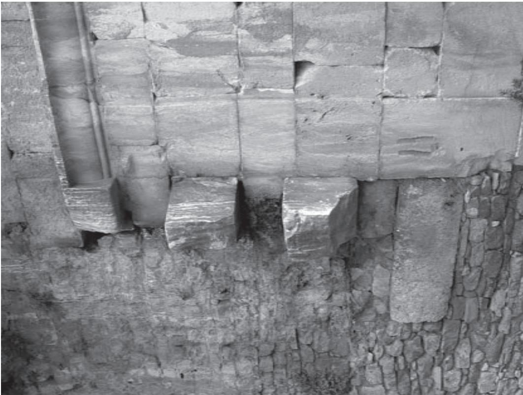
Abb. 26: „Wartesteine“ der ehemaligen Schildwand am Übergang vom hohen zum niedrigen Gewölbe im unteren südlichen Vomitorium S1.
