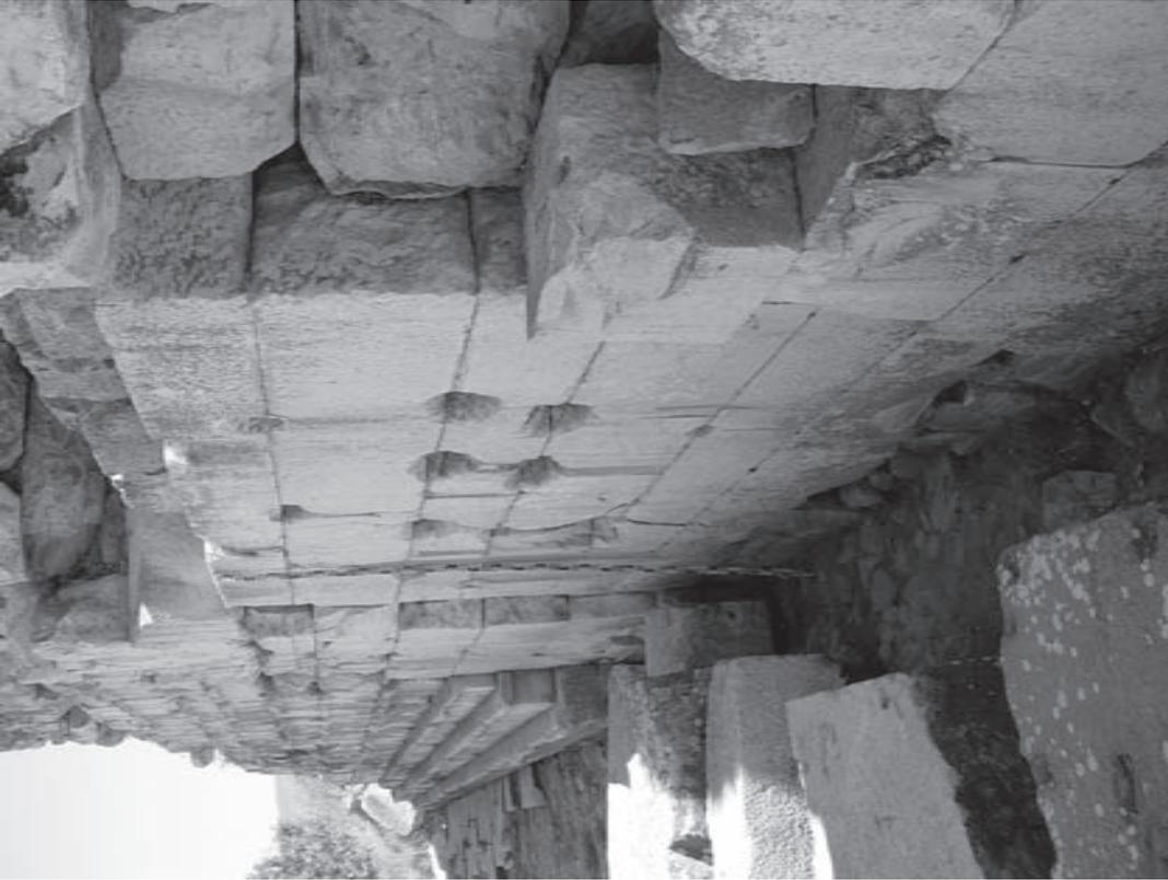
Abb. 37: Blick entlang des nördlichen Analemmas zur Gebäudeecke. Im Vordergrund ist sichtbar, wie der *opus caementitium*-Kern der vorgelagerten Terrasse gegen die Quader der Bogenfüllung läuft, während im Hintergrund der Laufbelag der Terrasse mit einem kleinen Unterschnitt unter die Sockelzone des treppenartig abgestuften Wandbereichs greift.
