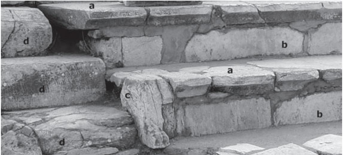
Abb. 14: Bauteile der Sitzstufenverkleidung aus Marmor.
