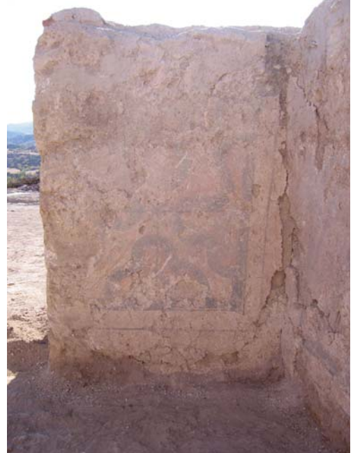
Abb. 12: Villa, Raum 3, Südmauer
