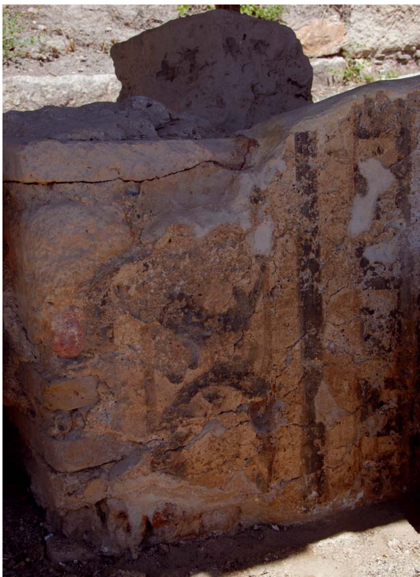
Abb. 5: Casa del cortile dorico, sala A 1207, stipite nord della porta verso lo stenopos 18
