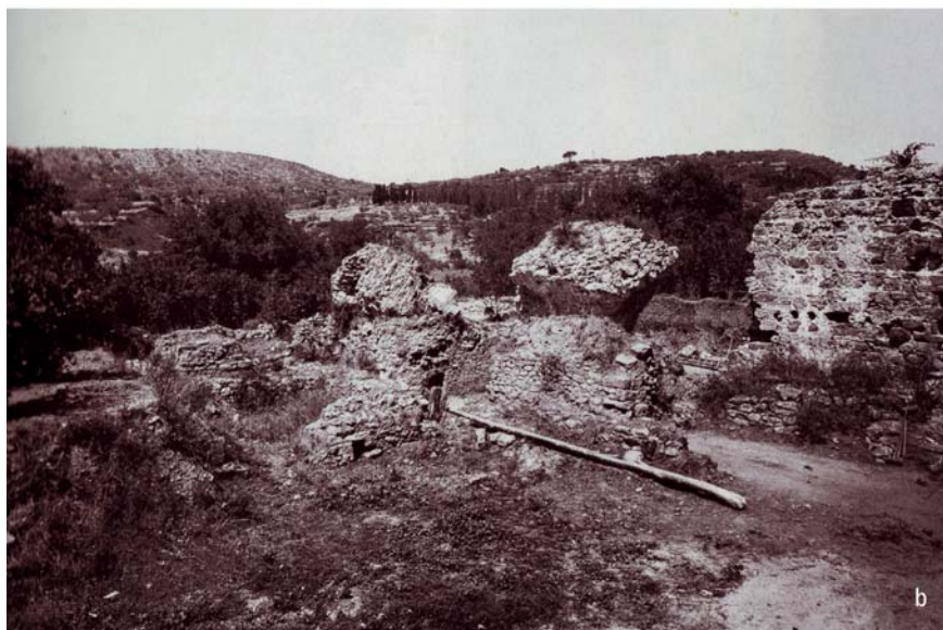
Abb. 2: Fronte sud di accesso villa con prospetto colonnato dell'arco dopo il restauro degli anni '60 (a) e prima (b), quando alcuni elementi in seguito crollati dei piloni ancora si trovavano in situ
