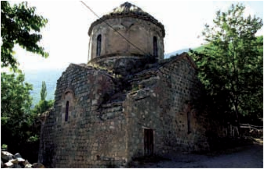
5 Dolisq'ana, Kreuzkuppelkirche, Ansicht von Südosten
