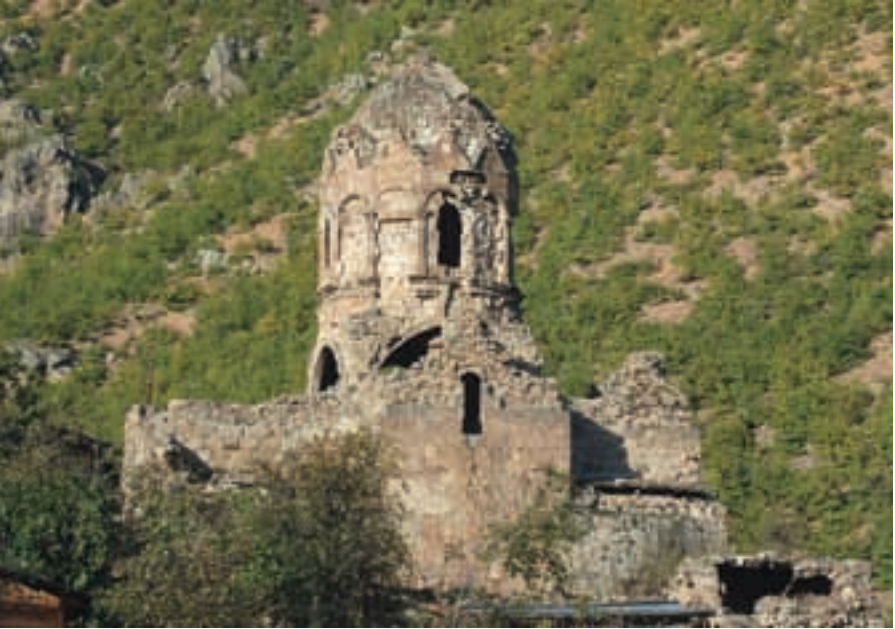
3 Xandzta, Hauptkirche des Klosters, Ansicht von Süden
