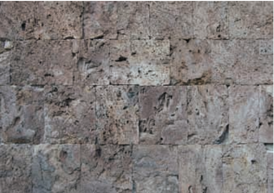
4 Xandzta, Quadersteinverschalung der Südfassade
