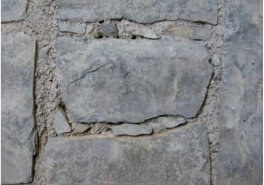
9 Esbek'i, Mauerverband im südlichen Seitenschiff (Detail)
